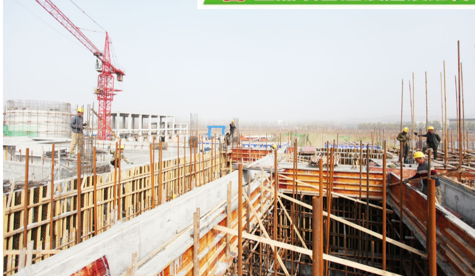
沁县现代农业产业示范区污水处理厂及配套管网建设项目总投资1.3482亿元,目前,一期工程已经完成70%。 秦超摄影报道
