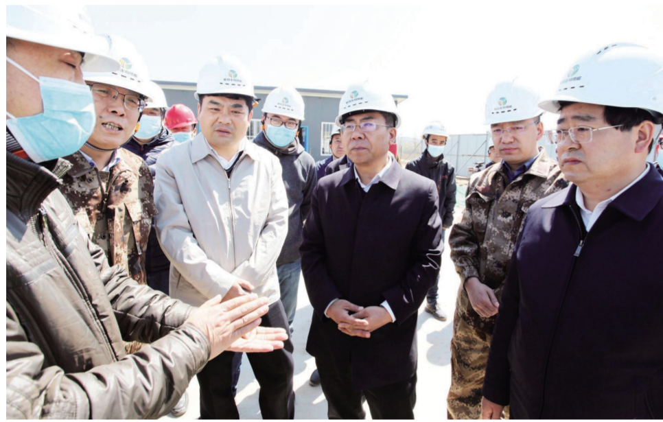
图为市委书记孙大军在山西能投生物质能综合利用沁县示范项目施工现场调研
