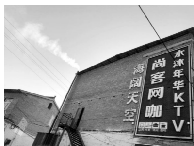
水沐年华燃煤锅炉排烟
