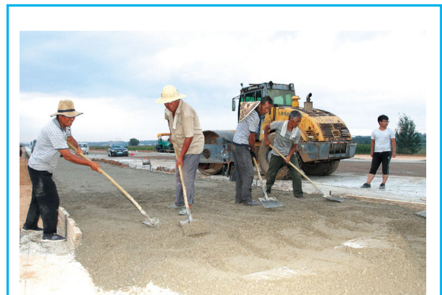
▲208国道至南涅水石刻馆旅游公路采用二级公路标准,设计速度60km/h,机动车道车道宽采用15m,路基宽采用30m,沥青砼路面结构,桥涵设计汽车荷载等级采用公路—I级,线路总长4.54km。目前部分路段已开始水稳铺装。 牛佳丽
