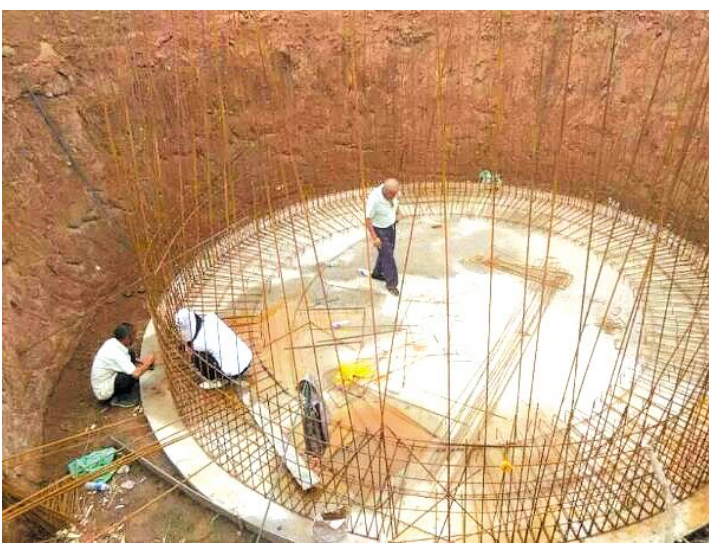
南里乡姚家岭村水池建设
