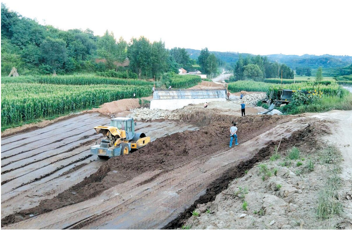
次村乡杨橙线路建设加速推进
