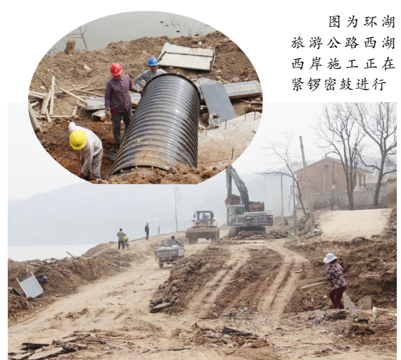
图为环湖旅游公路西岸施工正在紧锣密鼓进行。
