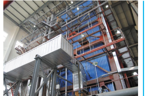
期供热管网11公里，全县受热面积累计75万平方米，近5000户居民和30多个单位受益，我县如期打赢了集中供热这场硬仗，兑现了县委、县政府向全县人民群众的承诺。
