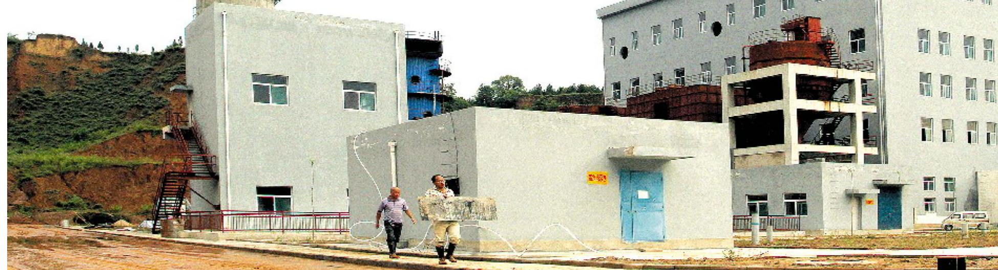
我县的集中供热工程于2012年2月立项,按照可研和设计方案,热源厂位于段柳乡长胜村牛家沟,占地89亩,建设规模为新建 $2 \times 58\text{MW}$ 煤粉锅炉(同时预留2台锅炉的安装位置),配套风烟系统、燃料运输系统、除尘、出灰渣系统、热水循环系统、水处理系统、供、排水、采暖及通风系统、供配电双轨线路及调节自控系统等,铺设一次管网总长度14882米,热力站25座,供热负荷96.32MW,供热能力168万平方米;工程总投资24345万元,其中申请亚行贷款14533.6万元,国内需配套资金9791.4万元。
