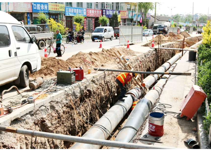
县城集中供热工程进展较快,截止目前主厂房、办公楼、80米烟筒、风烟系统、水处理系统土建工程基本完成,1号2号锅炉主体已安装完成,布袋除尘系统主体部分已完成,一次管网土建和安装工程全面开工正在紧张施工。 秦超摄影报道
