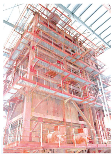
锅炉主体内部安装完成
