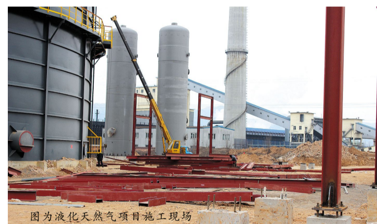
图为液化天然气项目施工现场
